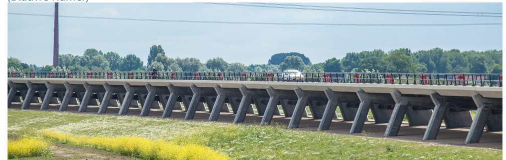
voorbeeld van een brug voor het doorlaten van water bij hoogwater (Veessen-Wapenveld)
