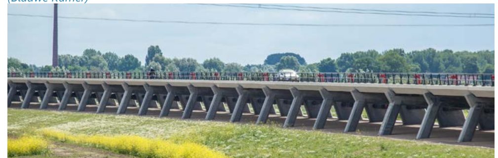
voorbeeld van een brug voor het doorlaten van water bij hoogwater (Veessen-Wapenveld)
