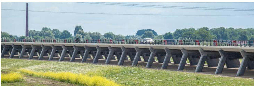
voorbeeld van een brug voor het doorlaten van water bij hoogwater (Veessen-Wapenveld)
