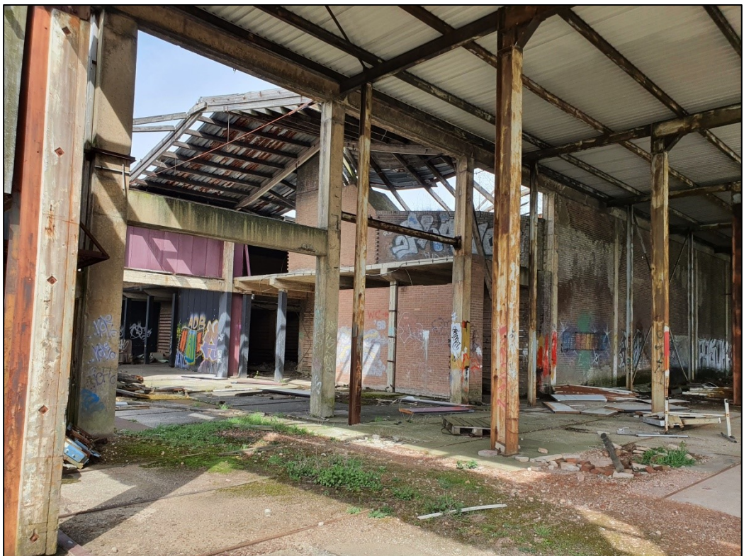
Figuur 5. Zicht op de binnenzijde van de fabriekshal. De foto is gemaakt in westelijke richting.
