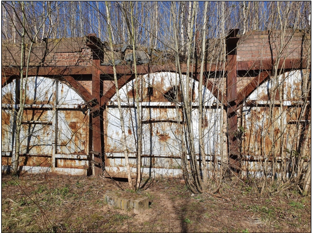
Figuur 2. Zicht op de vlamovens, een van de laatste restanten van voormalige steenfabriek Koppenwaard. De foto is gemaakt in westelijke richting.
